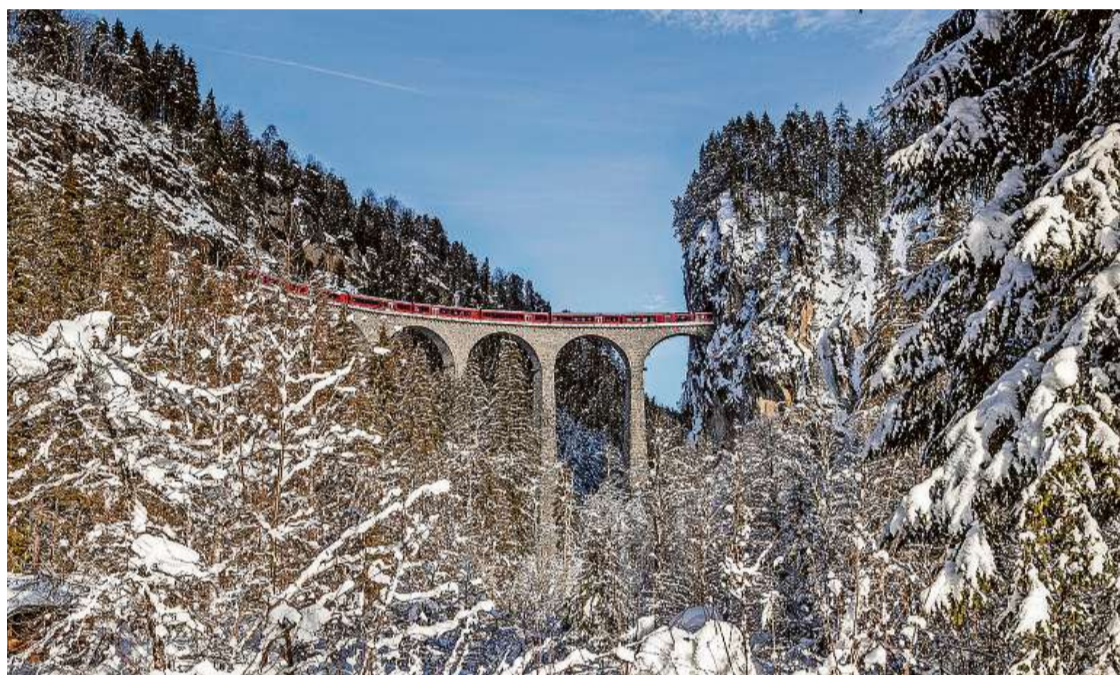
Steht im Mittelpunkt des Projekts: Der Landwasserviadukt soll Wahrzeichen Graubündens werden.
